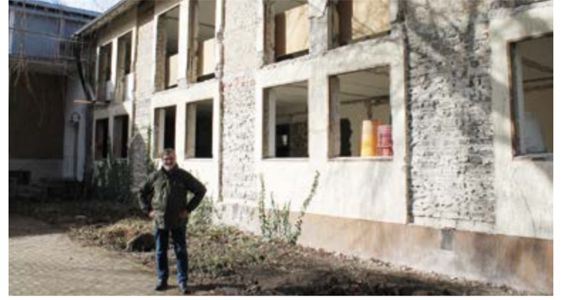
Das „Haus Bocholt“ in Rhede wird derzeit generalsaniert und aufgestockt. Internatsleiter Gregor Rippel freut's.
