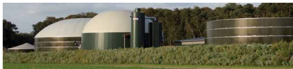
Die Biogasanlage vor den Toren des Klausenhofs
